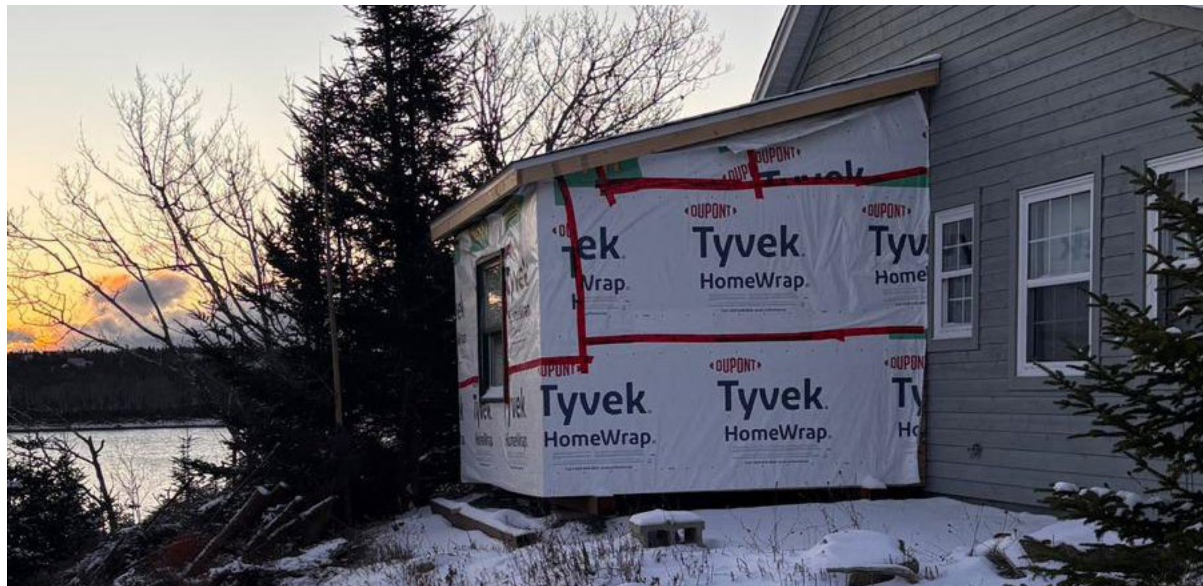
VON AUSSEN SCHEINT DER SCHUPPEN UNSCHINBAR, IM INNEREN HAT SICH ABER EIN HANDWERKERSCHATZ VERSTECKT
